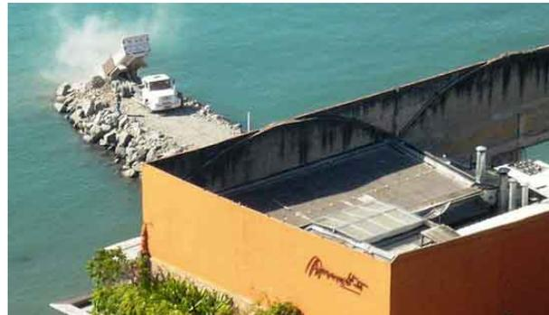
**Figura 02.** Caminhão realiza aterro sobre o mar para a construção da infraestrutura do restaurante. **Fonte:** Varela Notícias.
